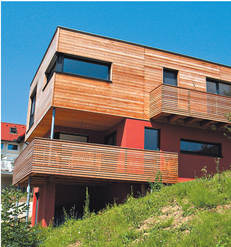
In der Halle gefertigt und doch ganz frei geplant: Architektenhäuser, in der Nische zwischen Fertig- und konventioneller Bauweise. [Schierl/Paris]
