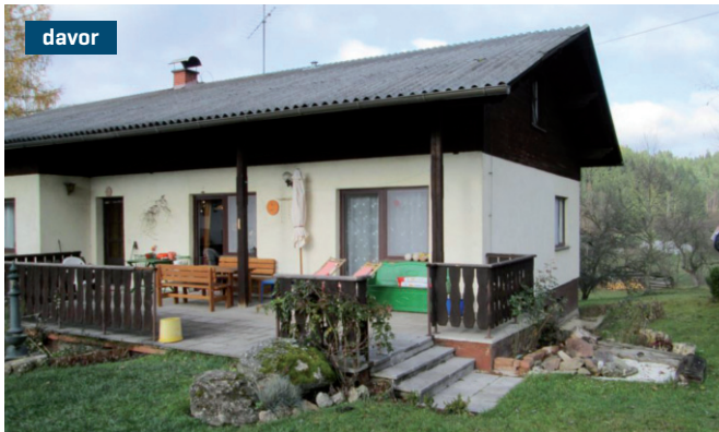
Dieses Haus aus den 1970er-Jahren diente als Musterbeispiel für die Kalkulation der thermischen Sanierung auf Seite 29. Neue Fassade, Dämmung und Fenster brachten laut Berechnung der EVN eine Einsparung beim Heizwärmebedarf um 75 Prozent. Die Kosten: rund 70.000 Euro
