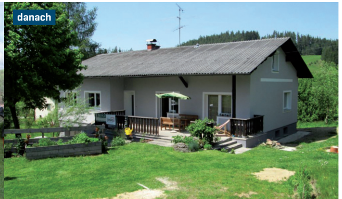
Dieses Haus aus den 1970er-Jahren diente als Musterbeispiel für die Kalkulation der thermischen Sanierung auf Seite 29. Neue Fassade, Dämmung und Fenster brachten laut Berechnung der EVN eine Einsparung beim Heizwärmebedarf um 75 Prozent. Die Kosten: rund 70.000 Euro
